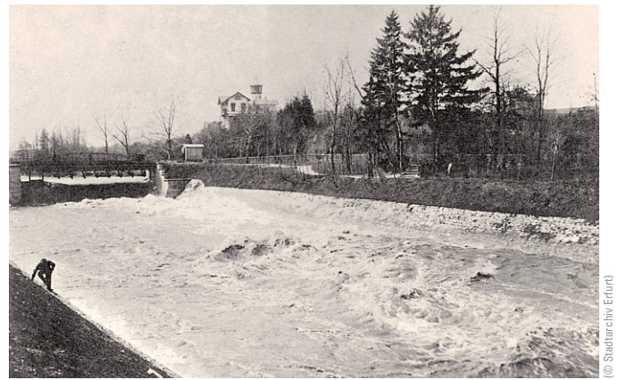
Bild 4 Flutgraben in Funktion – Hochwasser 1905 unterhalb des Papierwehres Flood ditch in operation – floods downstream of the ‘Papierwehr’ overflow dam in 1905
